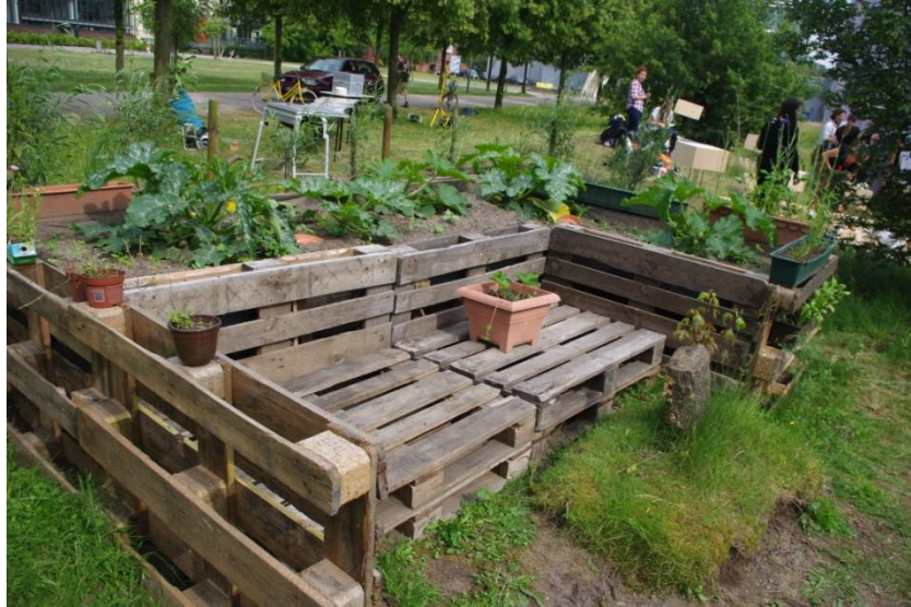
Abbildung 12: Hochbeet aus Euro-Paletten mit integrierter Sitzmöglichkeit
