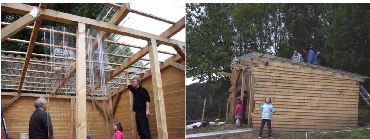
Abb. 7: Eindeckung der Hütte
