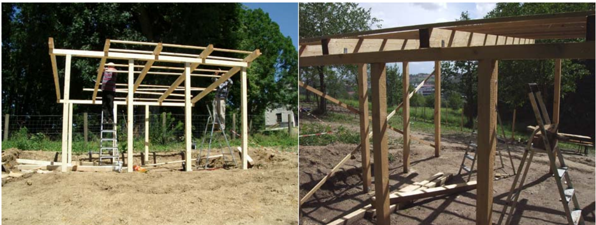
Abb. 4: Beginn des Baus des Geräteschuppens
