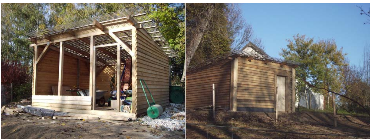
Abb. 10: Fertigstellung der Hütte
