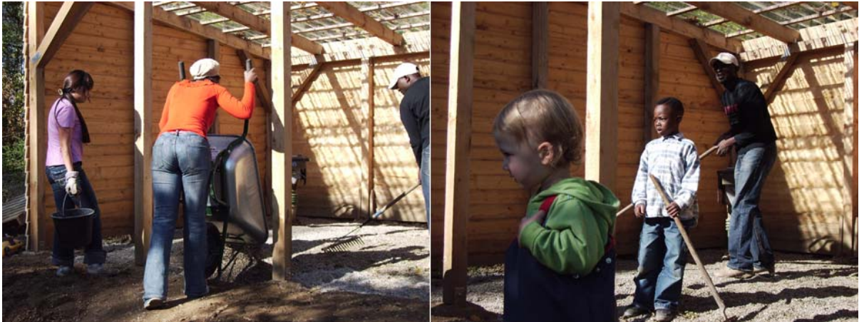
Abb. 8: Aufschüttung des Hüttenbodens mit Kies
