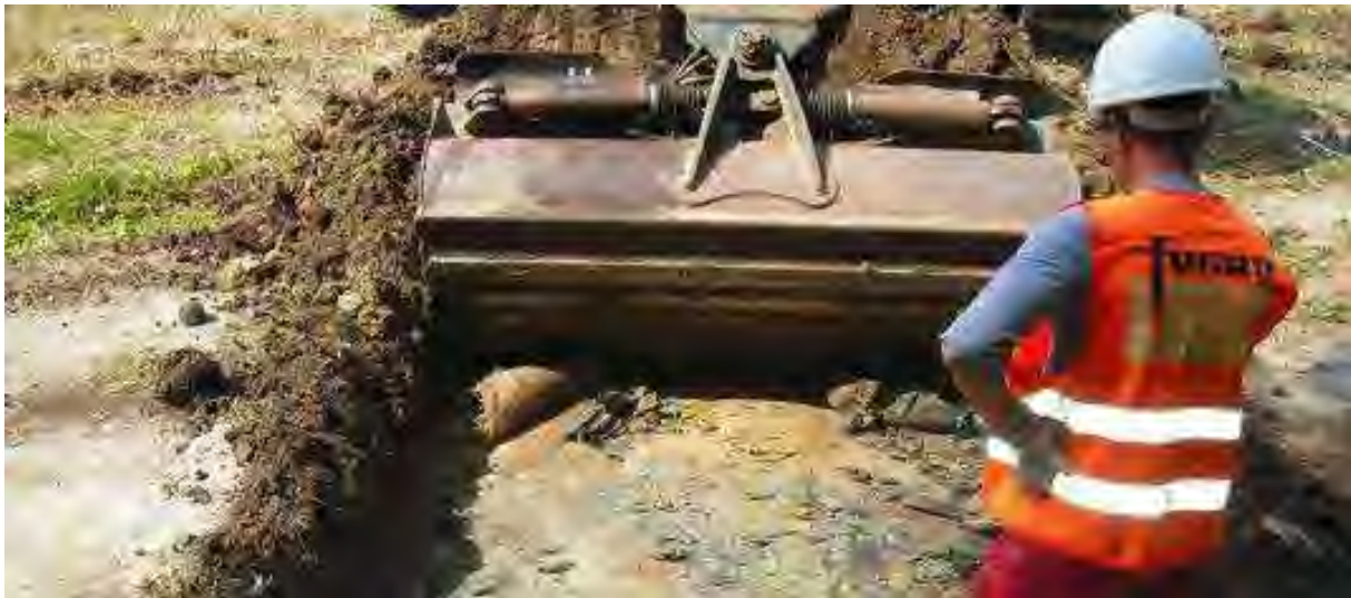
Abb. 6 Umfangreiche Sanierungsmaßnahmen erfordern oft den kostenintensiven Einsatz von Großmaschinen (Quelle: Website Fugro)
