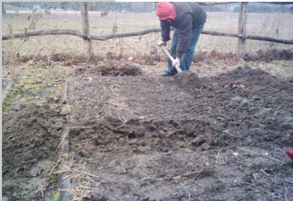
Los geht's: Auf der gewünschten Fläche den Boden mit abgeschrägten Seiten auf eine Tiefe von 15 - max. 20 cm ausheben.
