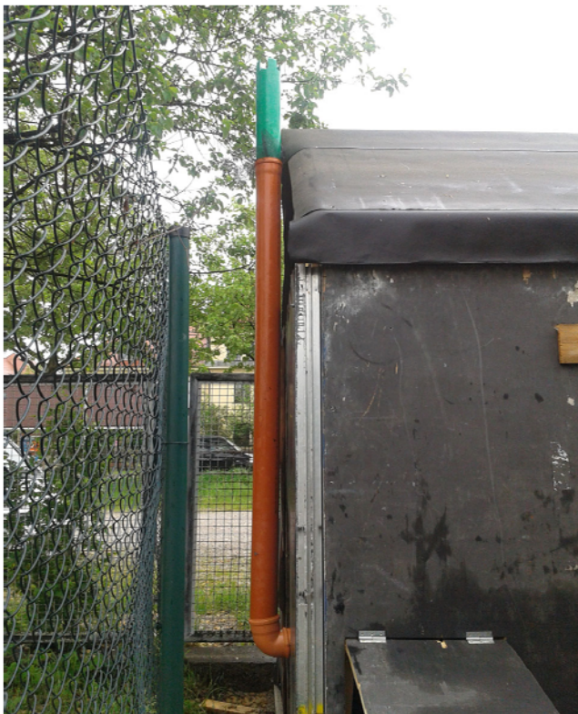
Abb. 15: montiertes Belüftungsrohr
