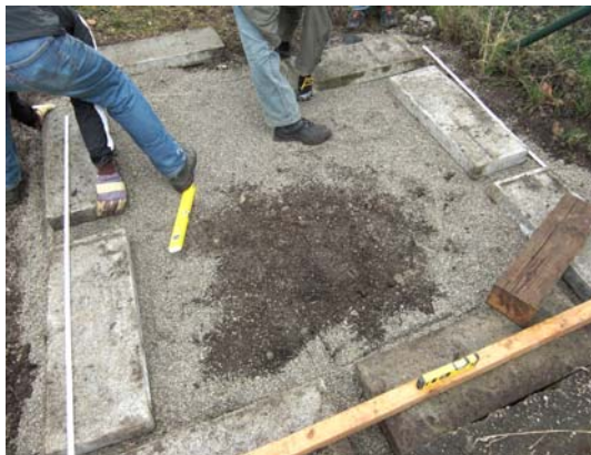
Abb. 2: Ausnivellieren der Betonsteine
