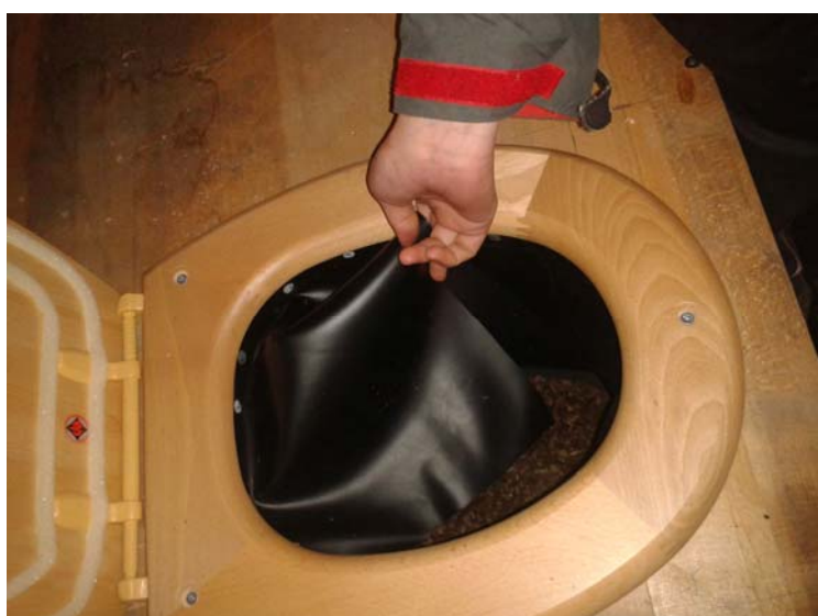
Abb. 7: Gummilappen der dafür sorgt dass alles sauber in die Tonne fällt
