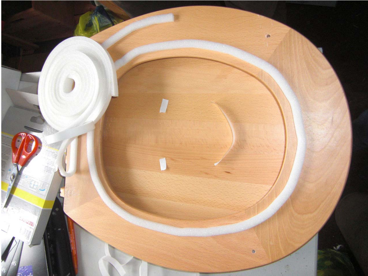
Abb. 8: Abdichtung der Klobrille
