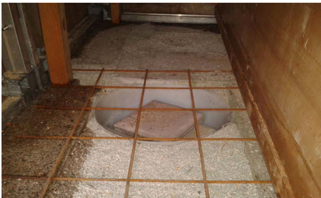
Abb. 10: Urin-Auffangschale unter der Sitzfläche
