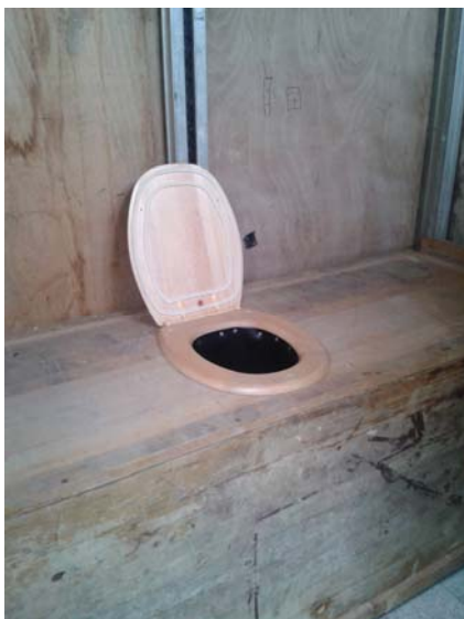
Abb. 6: Montage der Klobrille
