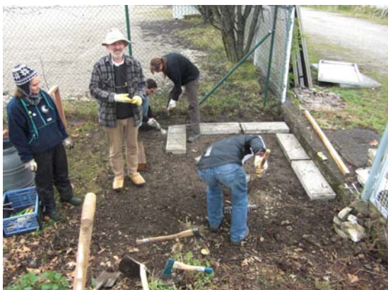
Abb. 1: Vorbereitung des Fundaments
